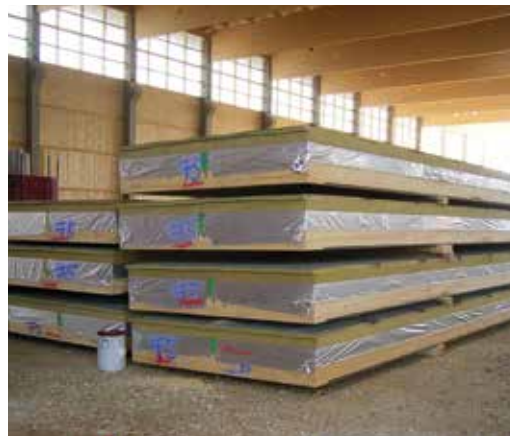
Abb. 4.5.3 Zwischenlagerung der Dachelemente
